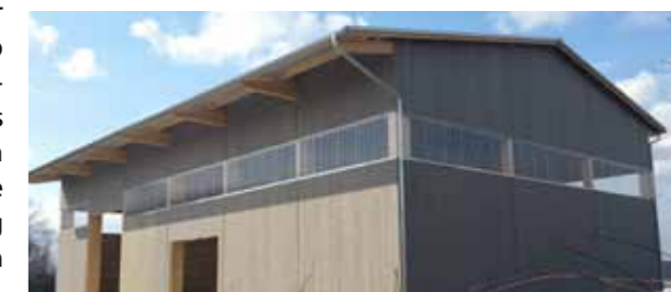
Der Brettschichtholzbausatz für Aicher Holzbau umfasste 5 Satteldachbinder sowie je 7 Einspann- und Pendelstützen.
