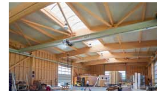
Das Tragwerk besteht aus 7 Kranbahnstützen mit BSH.
