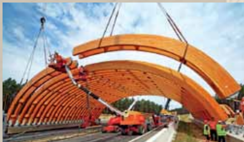
Die Grünbrücke besteht aus 50 Binderachsen mit einem Querschnitt von 20 bzw. 24x100 cm.
